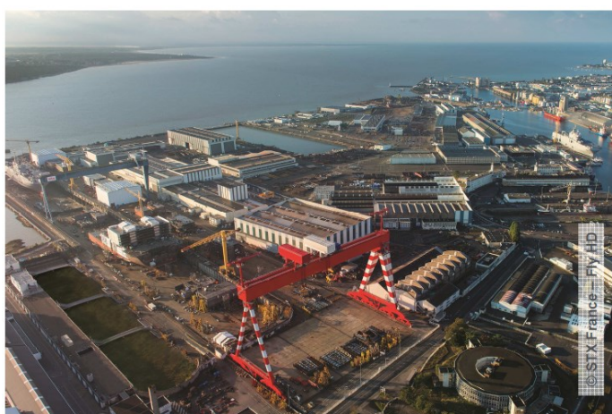
STX France SA - Vue aérienne du site Crédit : STX France - Fly HD
