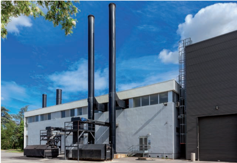
Vue de la façade arrière de la chaufferie
