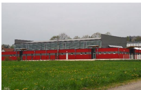
Vue extérieure du gymnase de Gy
