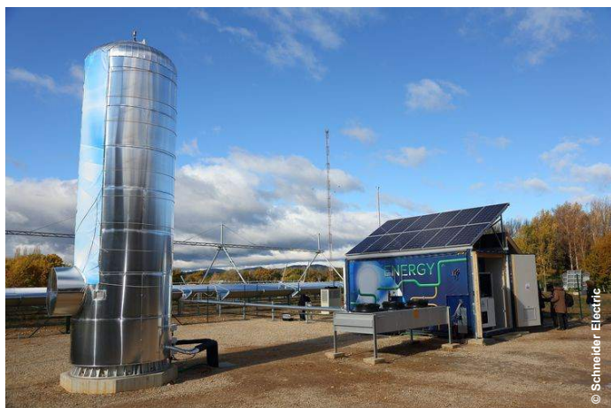
Unité de stockage et bâtiment destiné à la purification de l'eau, Cadarache
